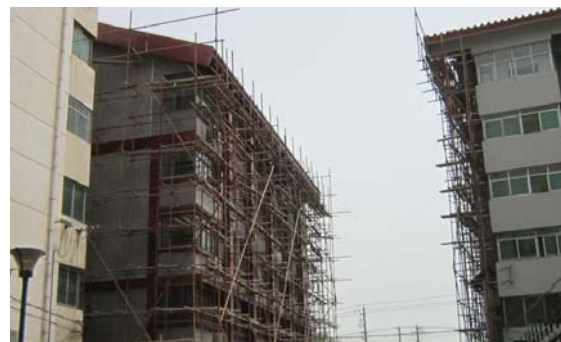
Nhà chung cư cũ đang được cải tạo
